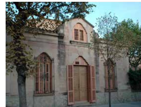
Coronades per arcs mixtilinis, les finestres i portes de la façana marquen la divisió entre la planta baixa i les golfes de l'edifici.
