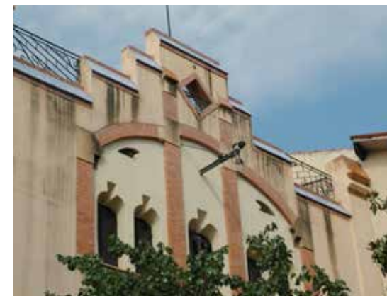
El capcer combina diferents materials: l'arrebossat, el maó vist, la teula plana de ceràmica i el ferro forjat de les baranes.
